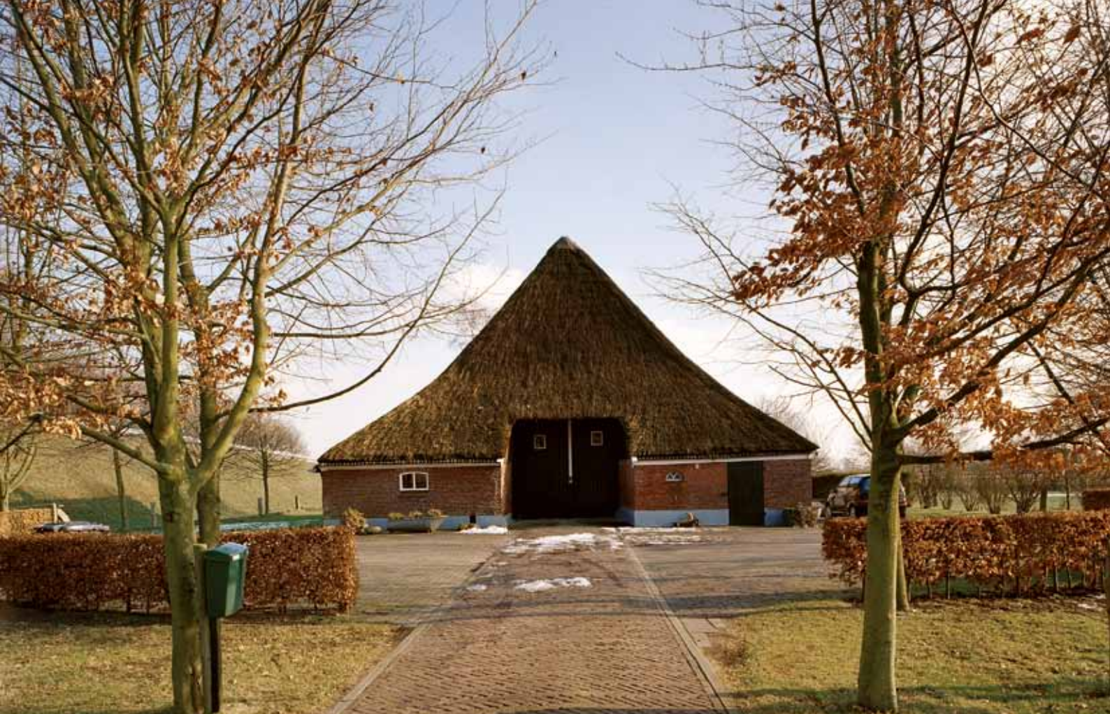
In lage gevels werden de baanderdeuren teruggelegd om toch de benodigde hoogte te krijgen om met volle karren naar binnen te rijden.
