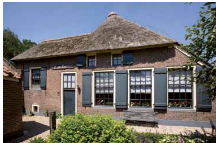
In de voorgevel van de boerderij zijn links de opkamer en de kelder te zien.
