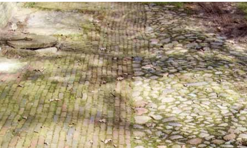
Erfverharding bestaande uit klinkers en keitjes. De oorspronkelijke erfverharding draagt bij aan de beleving van de boerderij.
