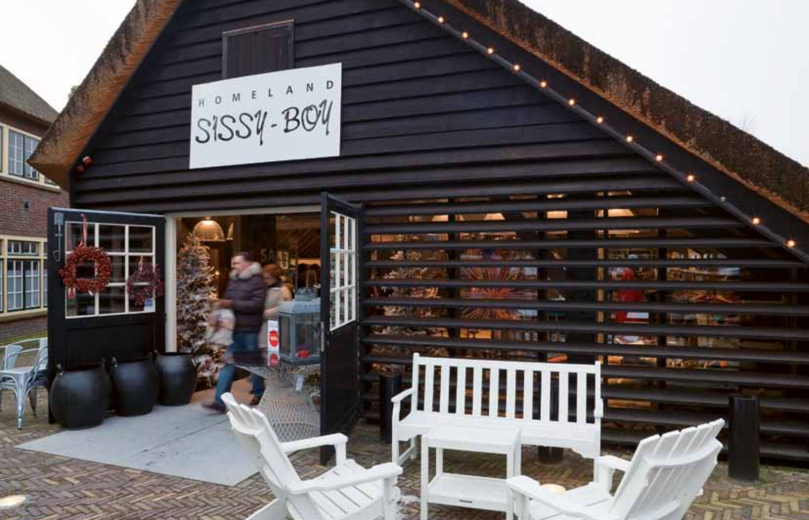
De houten planken van de gevel zijn als lamellen opengezet. Het karakter van de gevel blijft zo behouden, terwijl er toch daglicht in de winkel komt.
