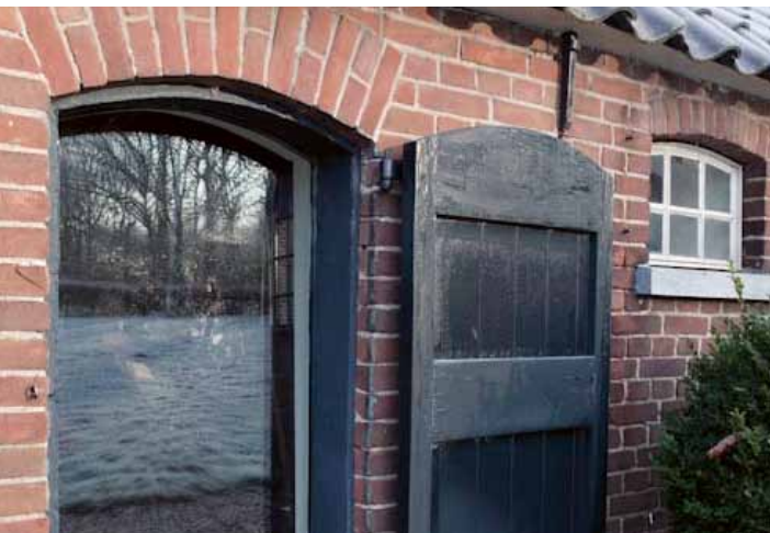
Aan de buitenzijde is het glas zichtbaar. De deuren zijn gehandhaafd, waardoor het aanzicht optimaal is behouden en deze ook nog gebruikt kunnen worden.
