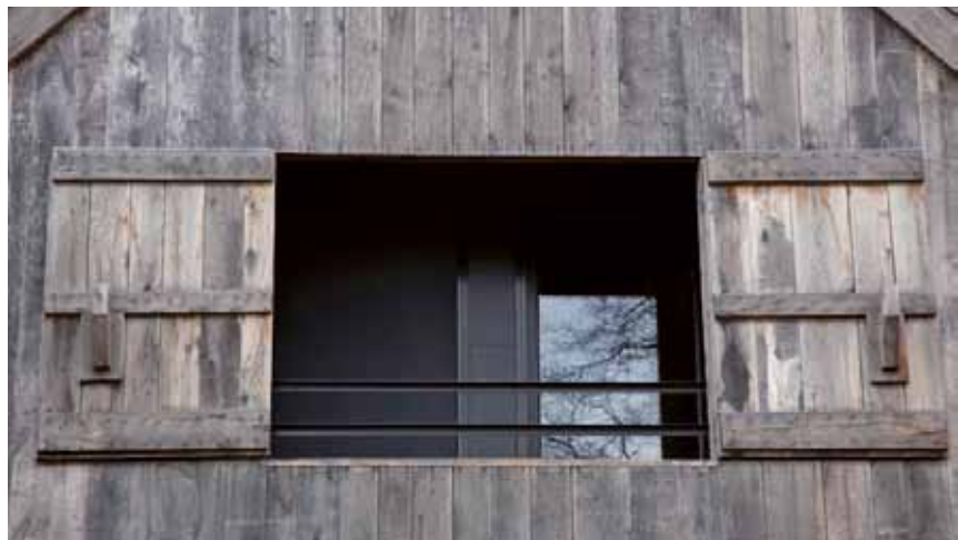
Achter de oorspronkelijke houten gevel is een nieuwe gevel geplaatst. Zo is een inpandig balkon ontstaan, waarbij het nieuwe glazen venster nauwelijks opvalt.
